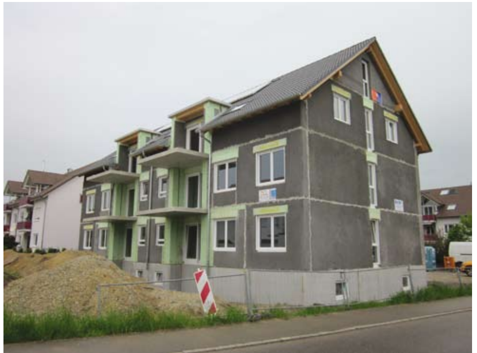
Bau des neuen Fertighauses (Foto: Spedition Steinhart)
